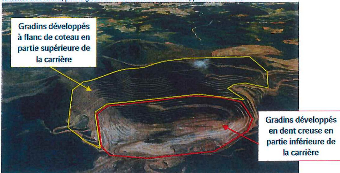
Exemple de carrière à flanc de coteau et en dent creuse
